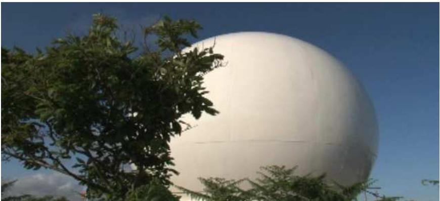
*Radôme de la station de réception directe d'images satellites radar Haute résolution VIGISAT.*
