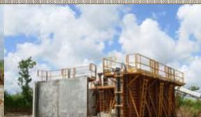
*Les banches de la station abritée, la station de contrôle de l'antenne.*
