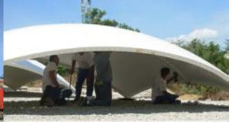
*L'assemblage du radôme requiert minutie, et des boulons par centaines fin juin*
