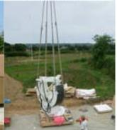
*Le radôme et la parabole sont assemblés au sol avant d'être hissés sur l'acrotère et le socle prévus pour les accueillir.*
